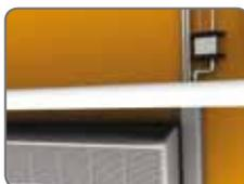
Поплавковый датчик подключается к конденсатному сливу кондиционера.
